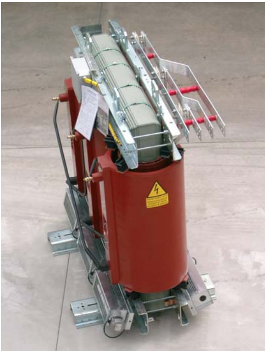
Фото 4. Пример исполнения выводов обмотки низкого напряжения нестандартной конфигурации
