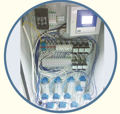
Шафа компенсації реактивної потужності в мережах міського зовнішнього освітлення
