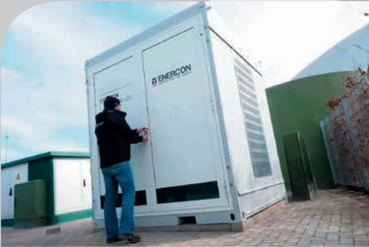
Компания Rittal представила на выставке Hannover Messe свои решения в области быстрого развертывания инфраструктуры для электромобилей. Как правило, в состав комплекса зарядной станции входит трансформаторная подстанция, контейнер для аккумуляторных батарей, а также различные корпуса для размещения силовой электроники. А для станции быстрой зарядки мощностью 350 кВт дополнительно требуется система охлаждения компонентов, которая также производится компанией Rittal.
