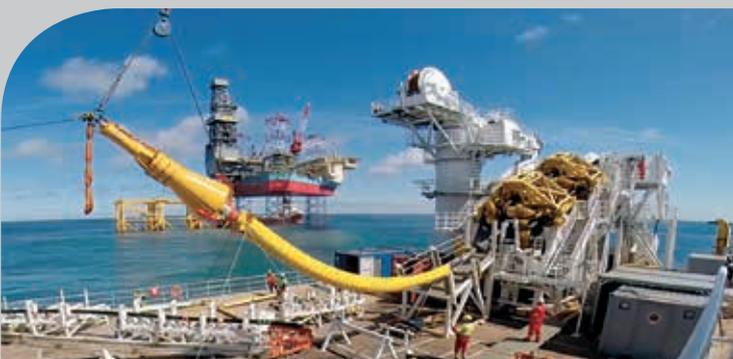
Международная компания NKT со штаб-квартирой в Дании поставила высоковольтную кабельную систему длиной 163 км для энергоснабжения с суши оборудования норвежского нефтегазового месторождения Martin Linge. В этом проекте проложен самый длинный в мире подводный кабель высокого напряжения переменного тока, который поможет предотвратить ежегодное выделение больших объемов CO<sub>2</sub>.
