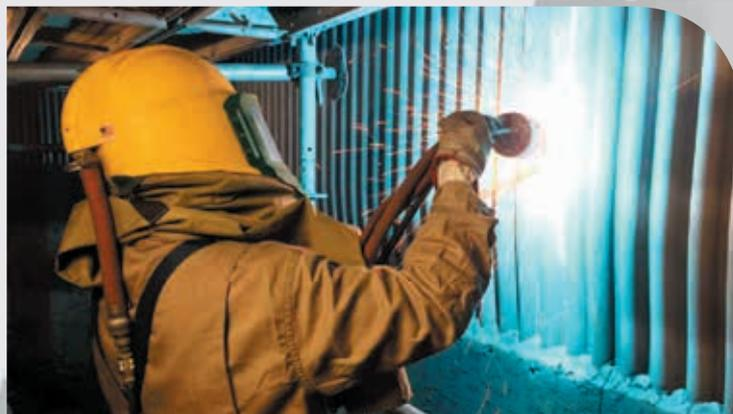
В частности, технология не требует длительного процесса подготовки поверхности и больших временных затрат на нанесение защитного покрытия, поэтому оборудование может быть возвращено в эксплуатацию сразу же по завершении операции металлонапыления. Кроме того, нанесение AmStar не вызывает деформаций металла, связанных с обработкой защищаемой поверхности, поскольку процесс происходит при низкой температуре, что дополнительно обеспечивает оборудованию сохранность.
