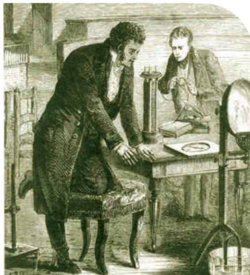
Эрстед держит проволоку над магнитной иглой, опирающейся на стержень. Игла отклоняется, когда электрический ток течет по проводу
