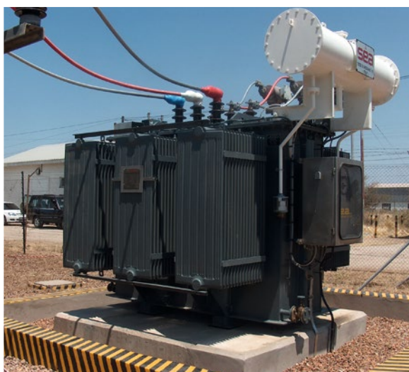
■ 10 МВАр реактор в Ботсване
