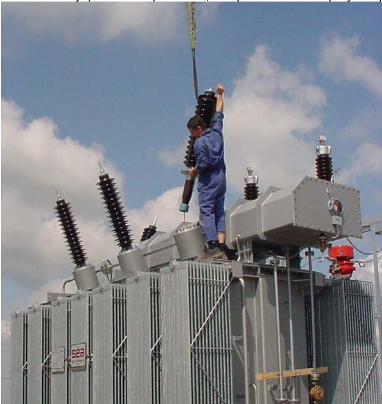
Рис.3 Сборка масляного трансформатора
