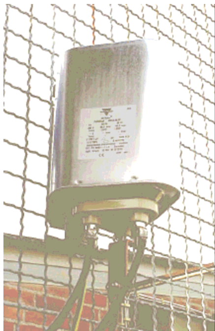
рис. 1 Внешний вид конденсатора серии PhMKDgF
